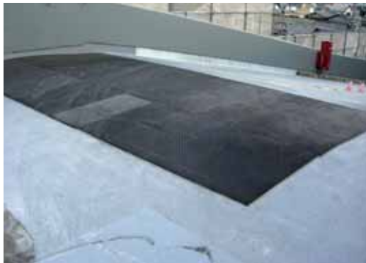
店舗 駐車場スロープ入口
